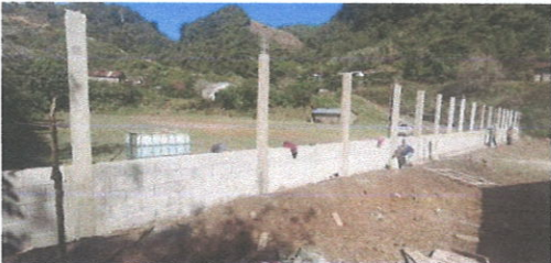
Foto 6: Mejoramiento y tallado de culmas del muro perimetral
