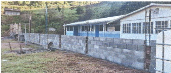
Foto 3: Mejoramiento del muro con las columnas
