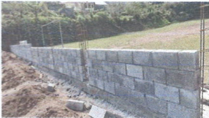
Foto 1: Mejoramiento del muro con las primeras ileras de block
