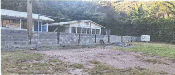
Foto 5: Mejoramiento y avance del muro perimetral
