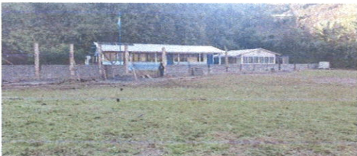
Foto 4: Mejoramiento del muro perimetral
